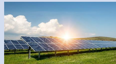
太陽光発電の架台
