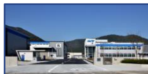
岡山事業所 岡山県赤磐市
